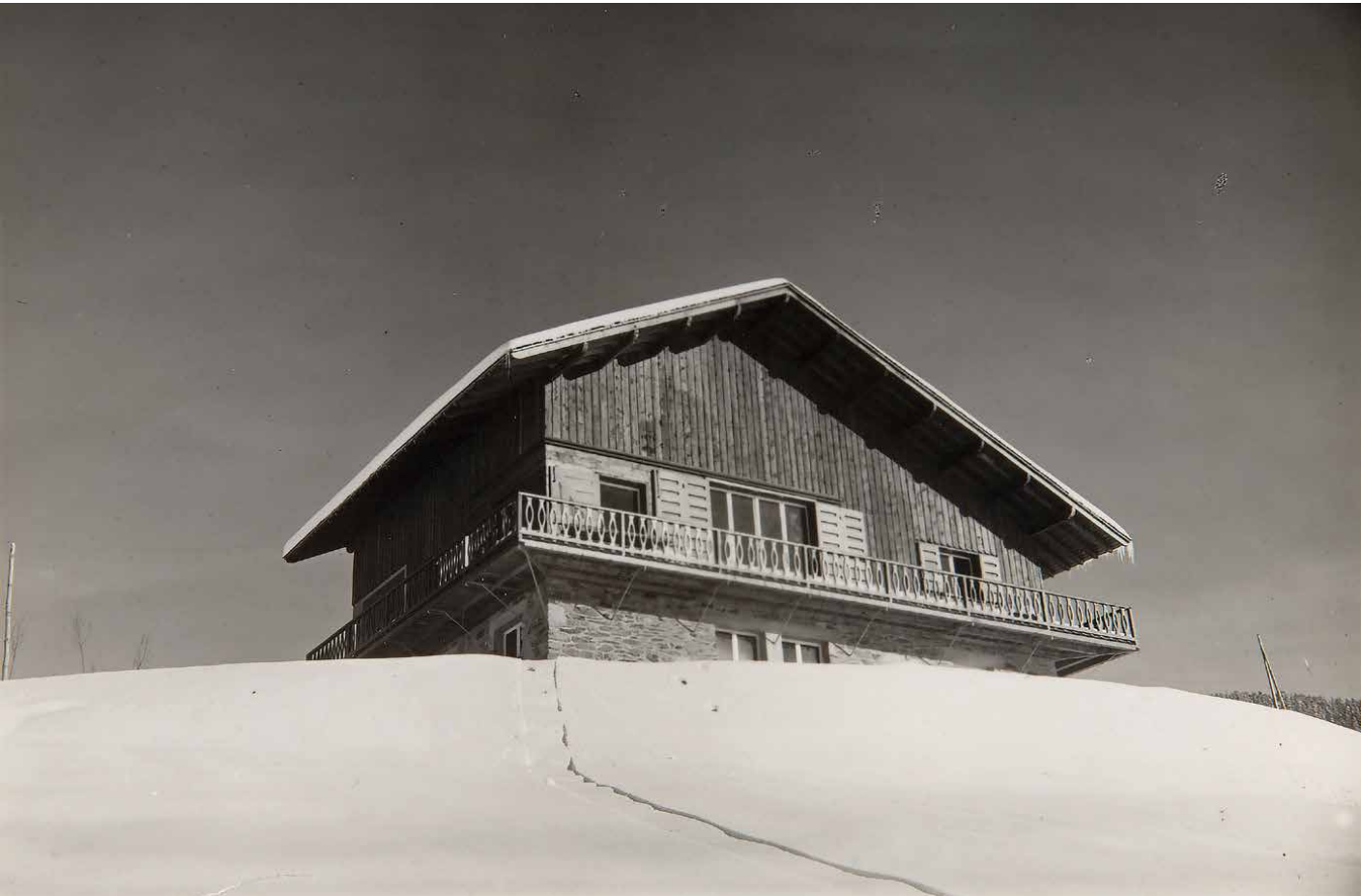
Le chalet Le Grizzly à Megève qui date de 1932 est l'un des rares labellisés « Patrimoine du XX e siècle ».
