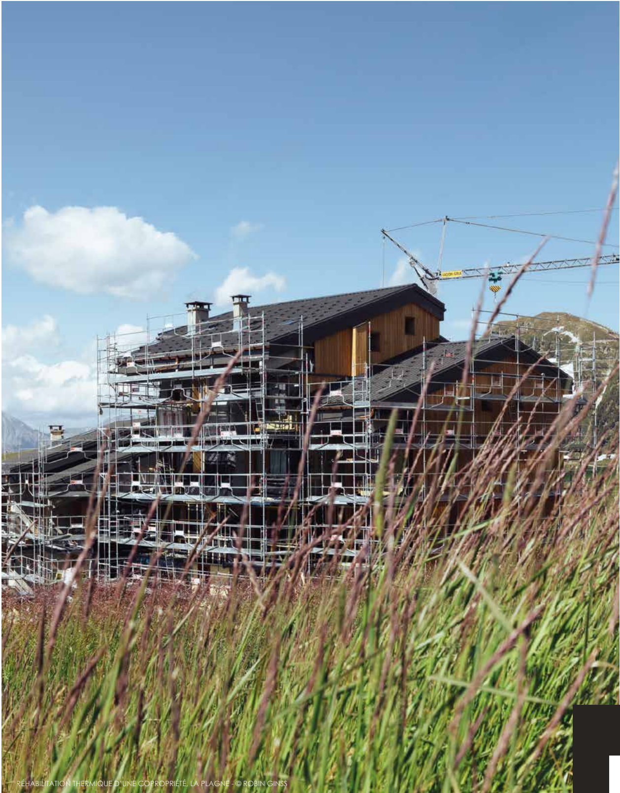
RÉHABILITATION THERMIQUE D'UNE COPROPRIÉTÉ, LA PLAGNE - © ROBIN GINSS
