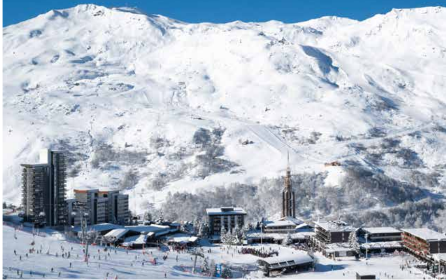
La galerie de la Croisette aux Menuires de 1640 m² a été rénovée en 2024. Elle concerne 60 commerces, 9 services de la station, 9 copropriétés (555 meublés).
